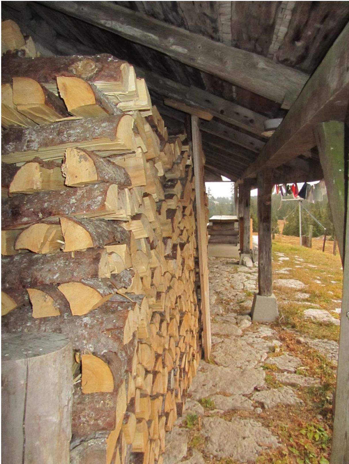
Un large avant-toit, avec pilier verticaux reposant sur des blocs de béton, découvre un espace suffisant pour y entreposer des stères de bois. Les tavillons d'autrefois sont encore visibles entre les lambris.
