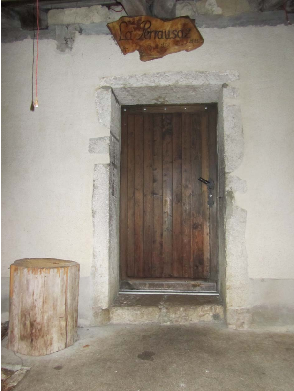
Porte d'entrée, date de construction du chalet inconnue.
