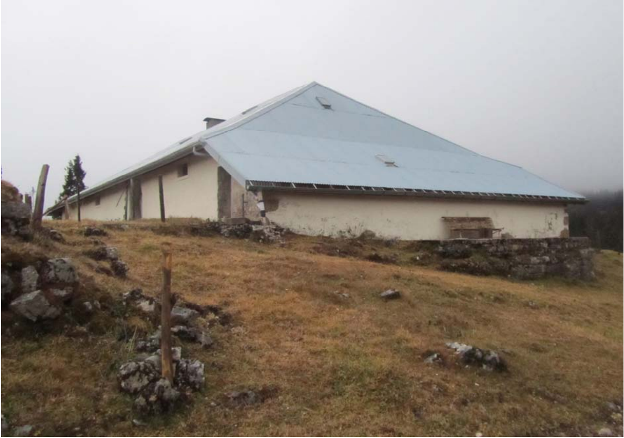
La pente du toit côté ouest protège aussi l'ancien boiton.
